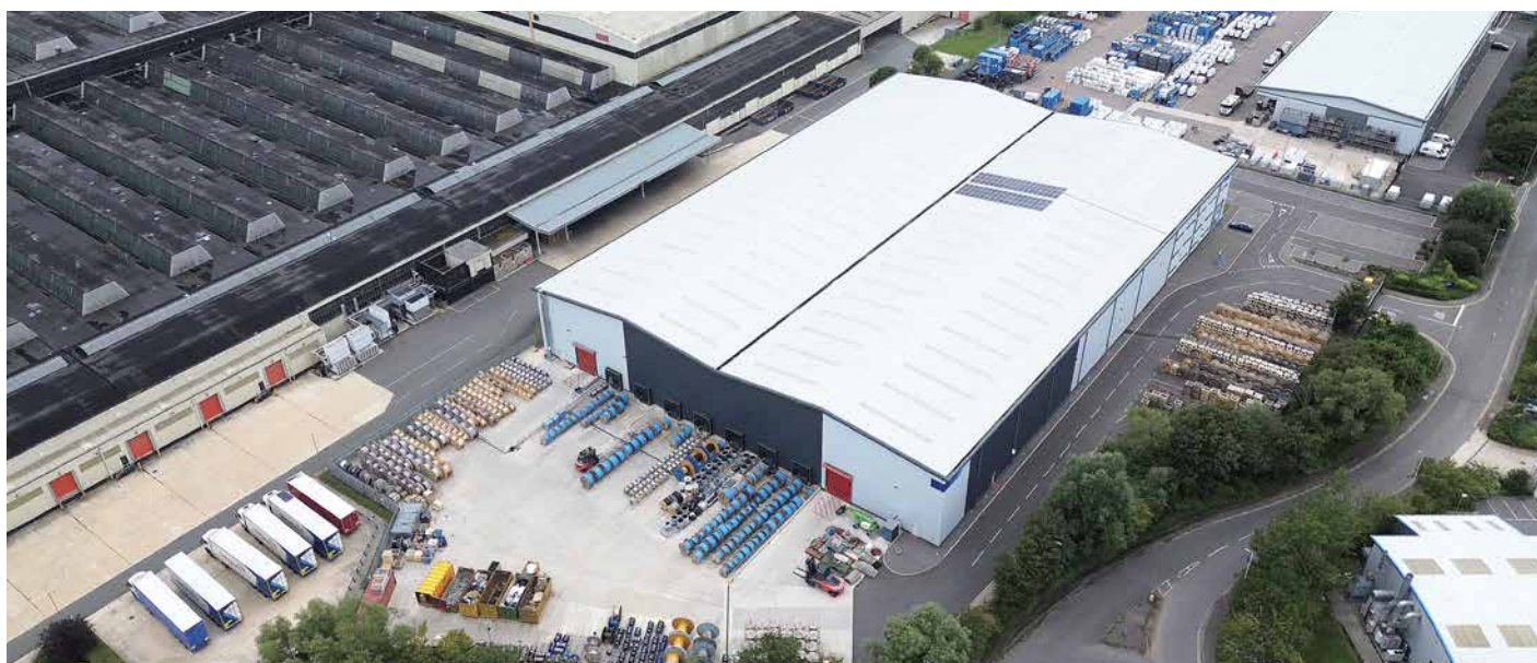
Figura 3 Sede Tratos Cavi UK Ltd con sede a Swindon – Regno Unito. Produzione cavi in fibra ottica, ombelicali per applicazioni sottomarine e cavi energia
