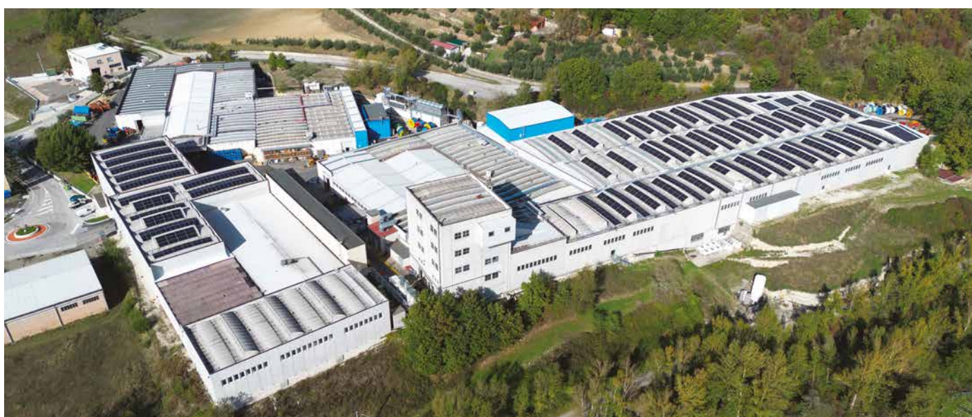
Figura 6 Installazione pannelli fotovoltaici presso Tratos HV
